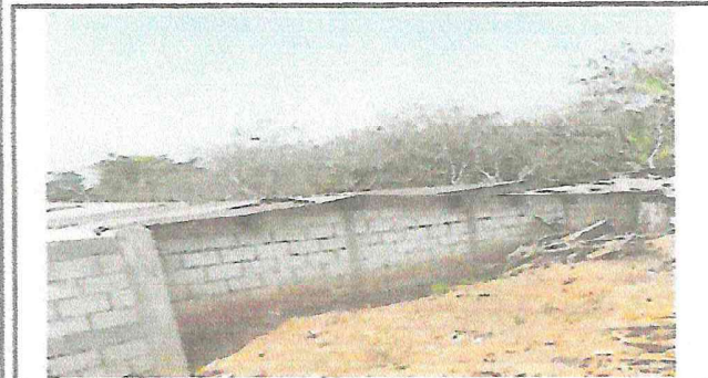
Foto 3: area desolada para bcontinuar el muro perietral.
