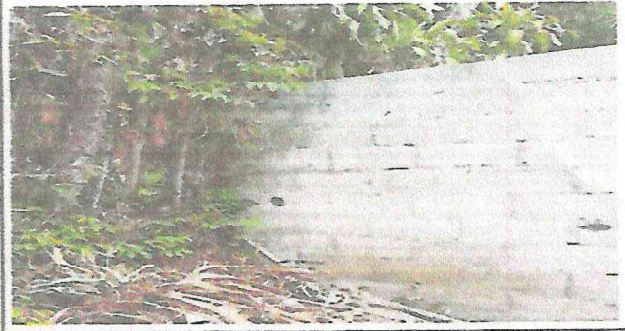
Foto 2: cubrir el muro perimetral por zona muy boscosa .
